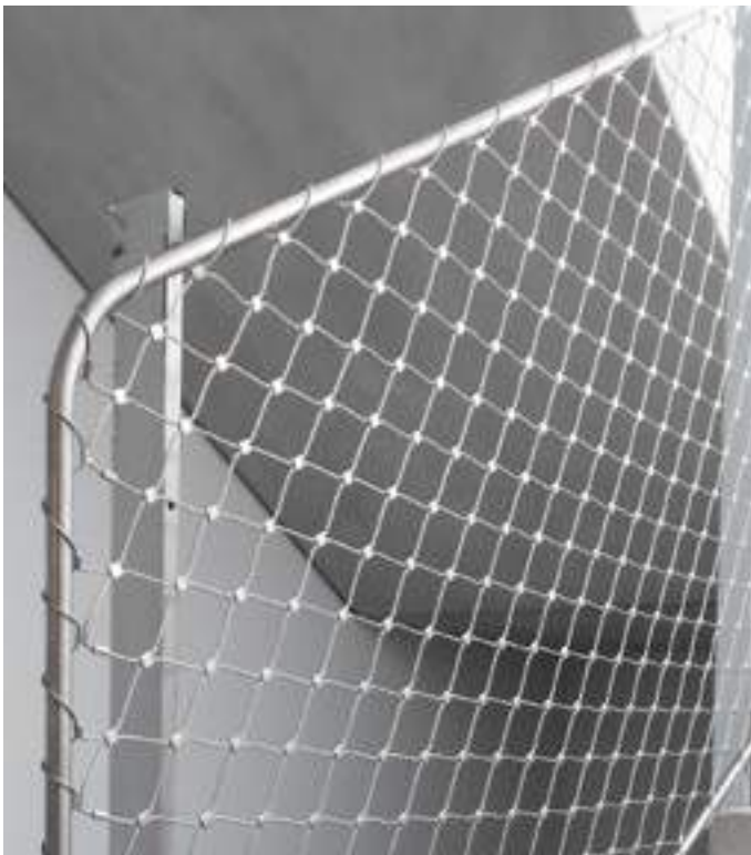
Schrägnetz, Masche parallel zu Ober-/Untergurt liegend Diagonal mesh panel, mesh diamond parallel to top and bottom tubes
